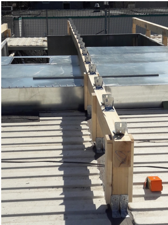
Abb. 2: Ansicht Holztragkonstruktion für Flachdach über Container
