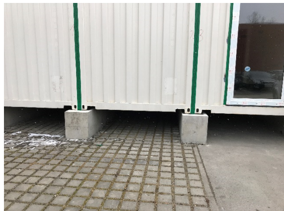
Abb. 4: Ansicht Container mit Streifenfundamenten auf Parkfläche
