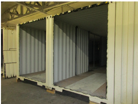
Abb. 3: Ansicht Container während Umbauphase
