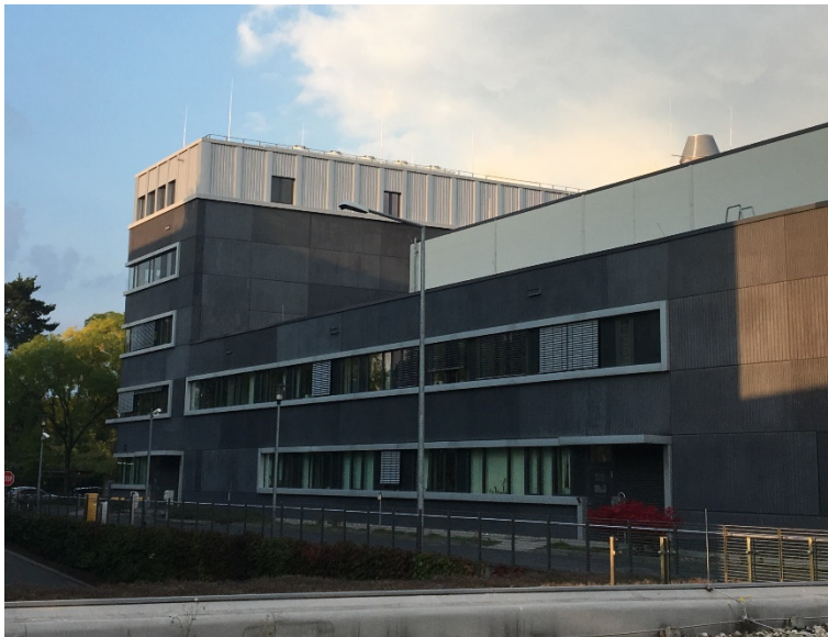
Abb. 1: Haus 60 mit fertiggestellter Aufstockung 4.OG
