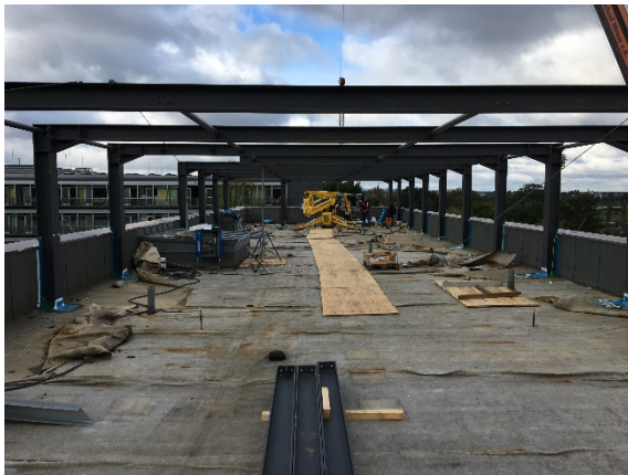
Abb. 2: Stahlrahmen während der Montage
