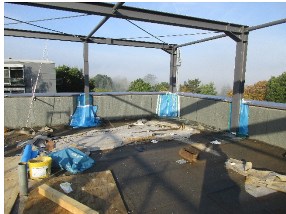
Abb. 3: Stahlstützen hinter vorhandener Attika
